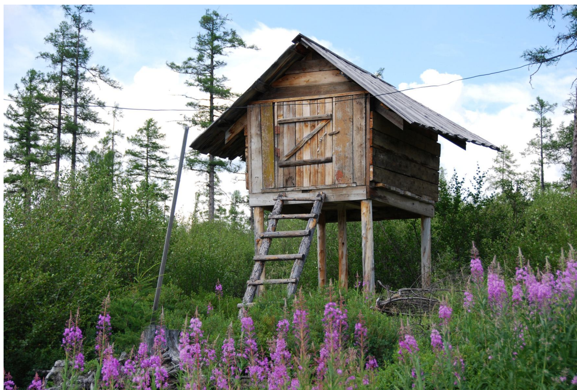
Fig. 6. An elevated storage room (labaz) needed to keep bears out Рис. 6. Надземное хранилище (лабаз), необходимое для защиты от медведей
