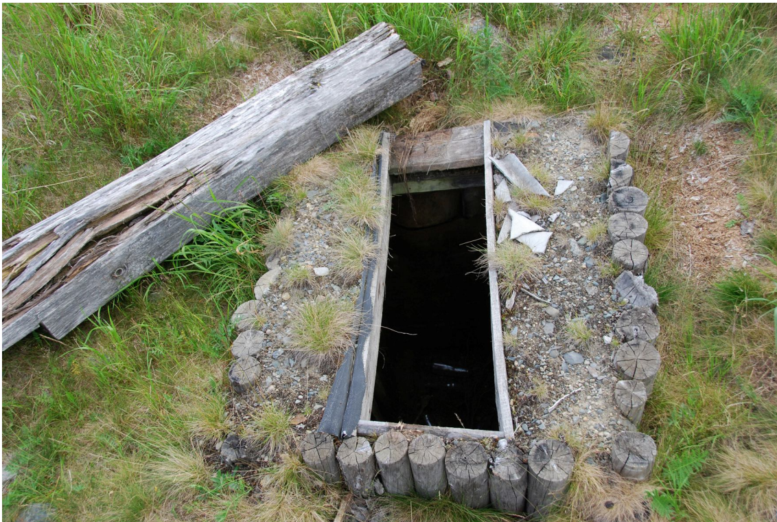
Fig. 10. An abandoned underground freezer (merzlotnik) Рис. 10. Заброшенный подземный морозильник (мерзлотник)
