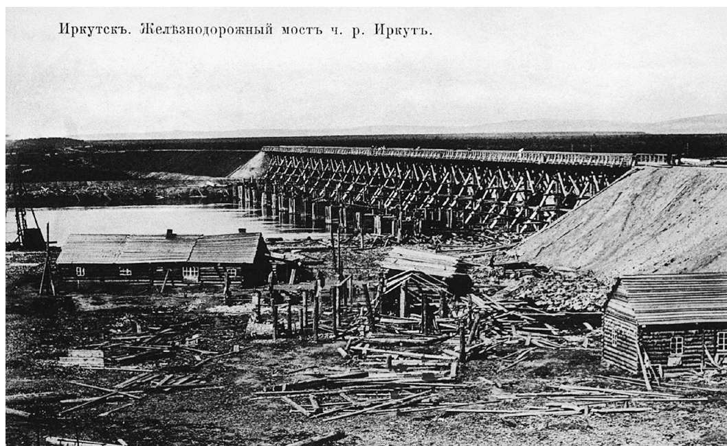
Рис. 4. Завершённый второй деревянный железнодорожный мост через реку Иркут, 0 верста ИБЖВ. Вид от Глазково. Почтовая открытка начала 1890-х. (Медведев, Куренков, 2016. С. 468)
