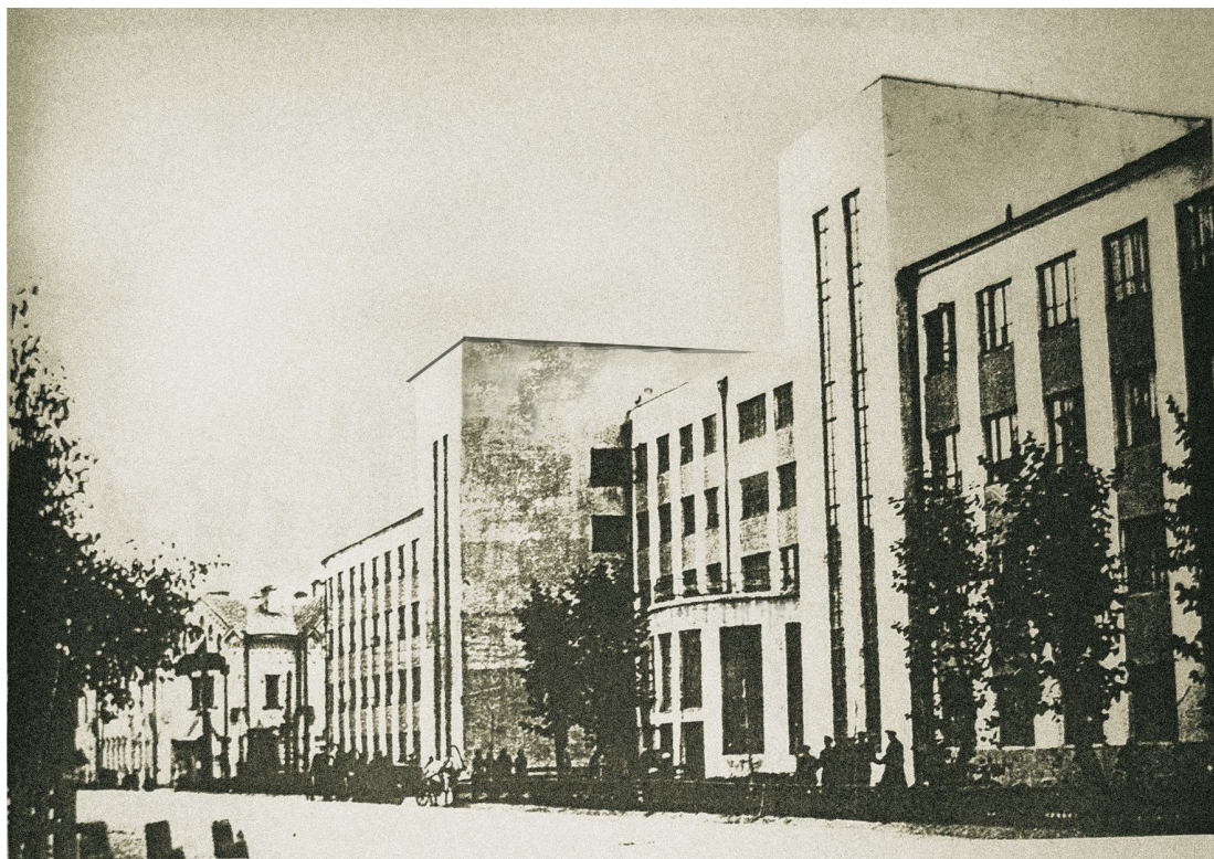
Рис. 4. Гостиница «Сибирь» (бывш. «Центральная»), 1934 г. (г. Иркутск, ул. Ленина, 18). Архив ИОЦСИКН Fig. 4. Hotel "Siberia" (formerly "Central"), 1934 (18 Lenin Str., Irkutsk). Archive of Irkutsk Regional Center for the Preservation of Historical and Cultural Heritage
