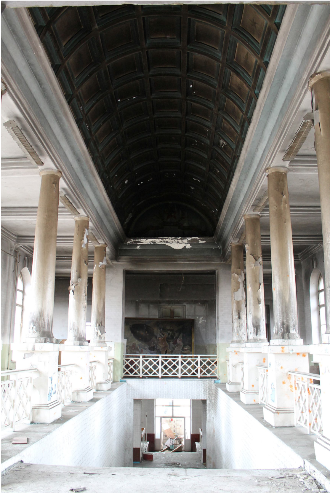
Рис. 6. Парадный вход главного корпуса, мраморная лестница, ведущая в «греческий зал», пострадавшая при пожаре в 2014 г.
