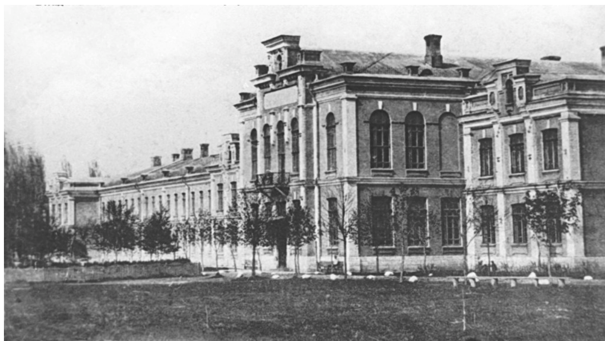
Рис. 2. Здание главного Владикавказского кадетского корпуса, по образцу которого производилось планирование и постройка корпусов военного училища в Иркутске. Начало XX века Фото с сайта http://khalinin.livejournal.com/3070.htm
