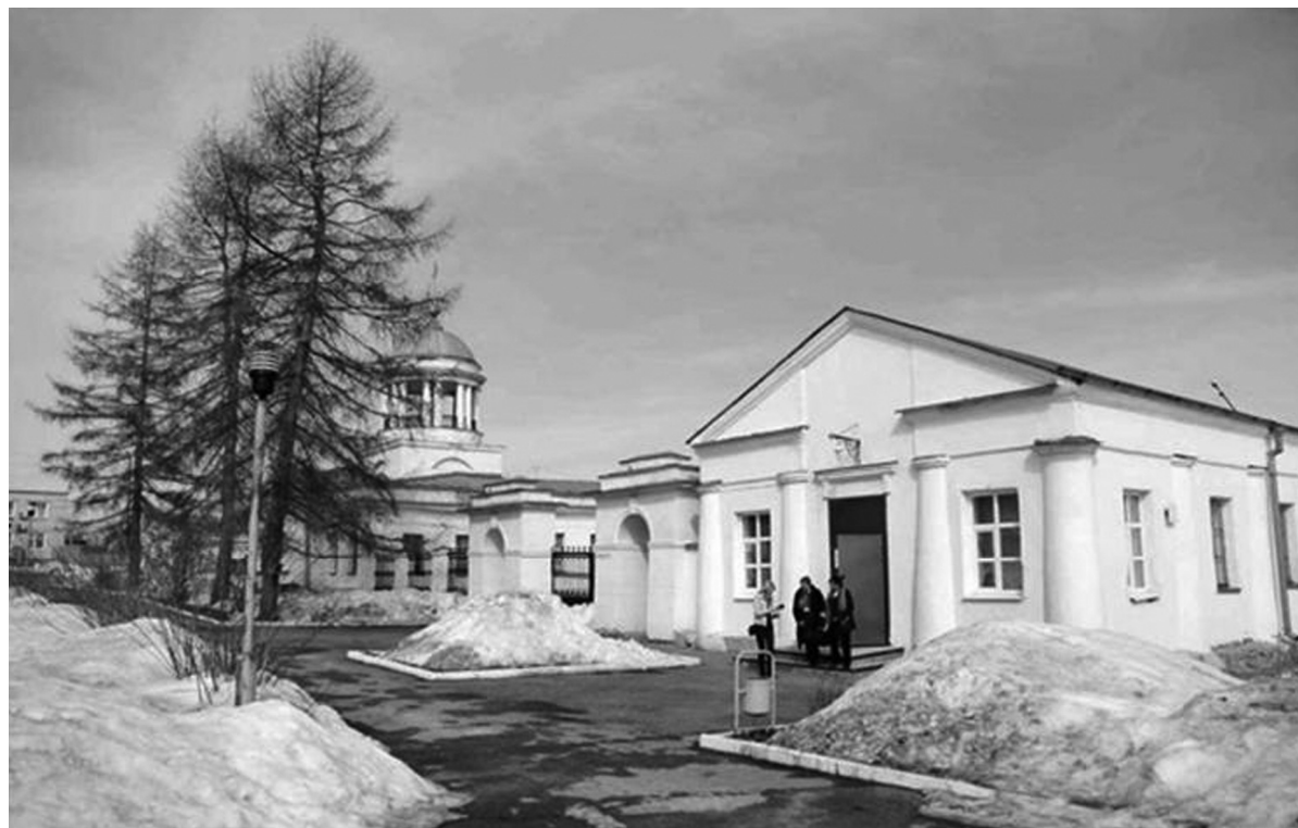
Рис. 2. Здание заводоуправления Каменского металлургического завода и дом, в котором проживал управляющий
